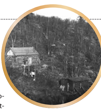
Morgamin kultalaa turvesaunoineen 1940- ja 1950-luvun vaihteessa.
